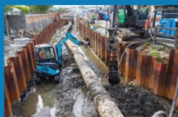
Mini digger/excavator © alamy
